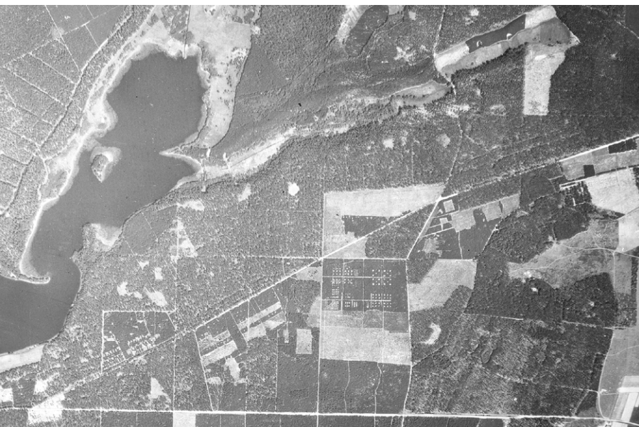
Luftbild von 1953 mit noch sichtbaren Waldlager- Strukturen und Zeltstätten, Hoppegarten bei Müncheberg, Lkr. Märkisch-Oderland
