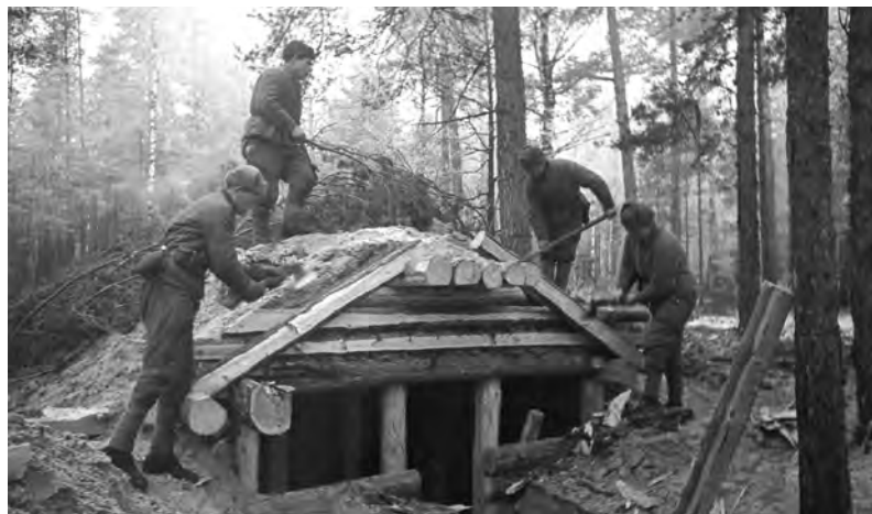
Abb. 16: Bau einer Semljanka durch Pioniere 1939
